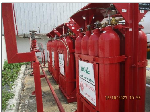
รูปที่ 3-45 การจัดเก็บก๊าซไฮโดรเจนสำรอง
