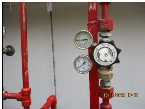
รูปที่ 3-48 ข้อความแสดงทิศทางการหมุนของวาล์วควบคุม ก๊าซและลูกศรแสดงทิศทางการไหลของก๊าซภายในท่อ
