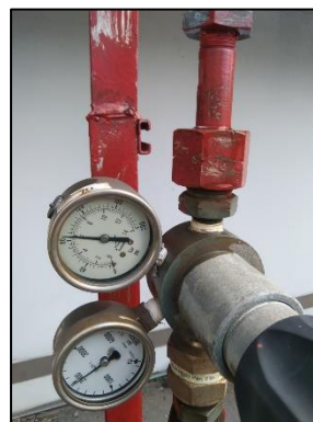
รูปที่ 3-50 อุปกรณ์ป้องกันก๊าซไหลกลับในท่อ (Check Valve)
