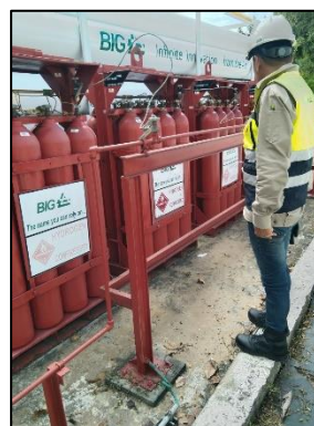
รูปที่ 3-46 การเก็บก๊าซไฮโดรเจนที่มีอากาศถ่ายเท
