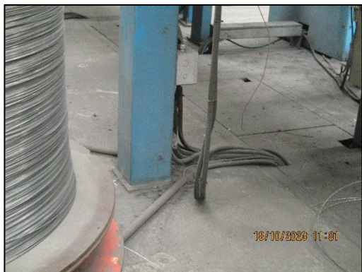
รูปที่ 3-41 สายดินบริเวณเครื่องจักร
